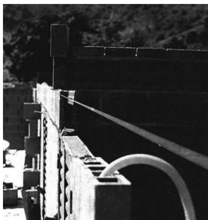
Figura 3 - Utilização dos blocos de formato especial na execução de vergas e cintas. Fonte: Urbel.
