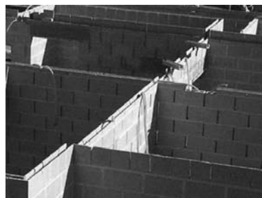
Figura 4 - Instalações feitas no interior dos furos dos blocos. Fonte: Urbel.
