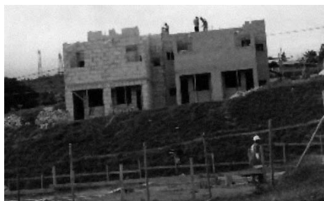
Figura 2 – Unidades habitacionais em construção. Fonte: Urbel.
