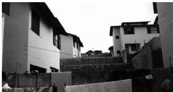
Figura 10 - Detalhe do tipo de uso do espaço interno do lote. Fonte: Urbel.
