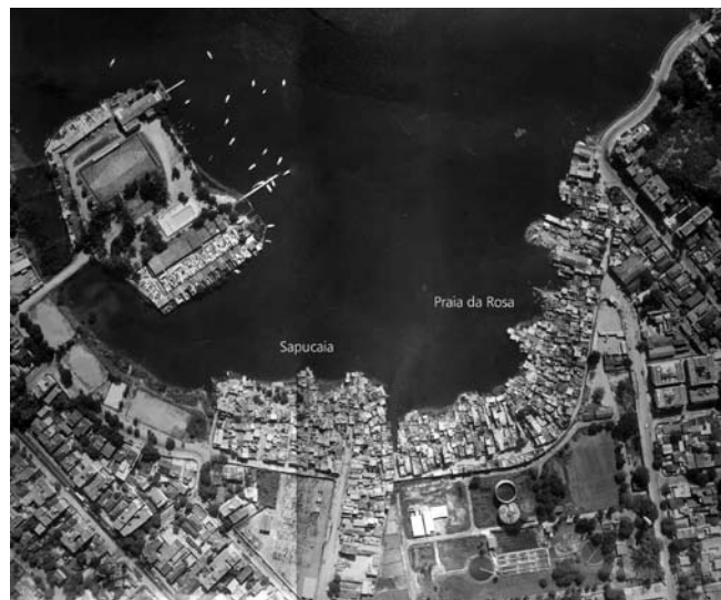
Foto 1 - Vista aérea das favelas, antes das obras.. Fonte: IplanRio, SMH, Observatório Ippur/UFRJ-Fase.
