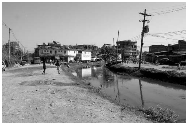
Foto 21 - Prédios de dois ou mais pavimentos, em via não pavimentada. Fonte: Observatório Ippur/UFRJ-Fase
