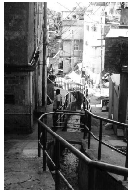
Foto 12 - Pelo sistema de drenagem, correm também lixo e esgoto. Fonte: Observatório Ippur/UFRJ-Fase
